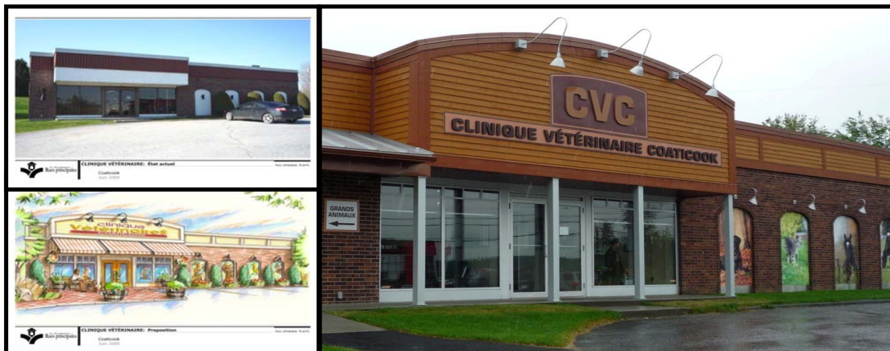
Image 24 – Exemple d’une rénovation de façade d’un commerce de Coaticook
