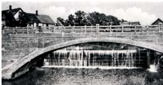
Collection de la Société d'histoire de Coaticook — Barrage au pont de la rue Saint-Paul.
